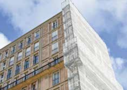
lot v40 en cours de restauration, Le Havre
