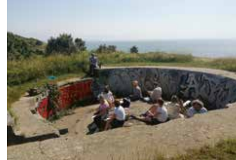
Batterie de Dollemard, Sainte-Adresse
