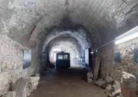
Tunnel Sainte-Marie, Le Havre
