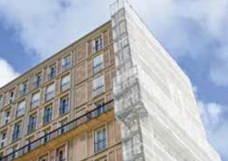
Îlot v40 en cours de restauration, Le Havre
