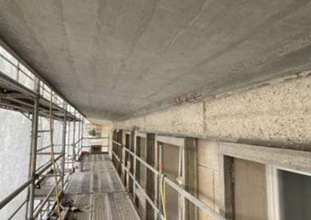
Chantier de restauration : îlot S85, Le Havre
