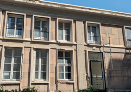
Îlot S85 : façade en cours de restauration, Le Havre
