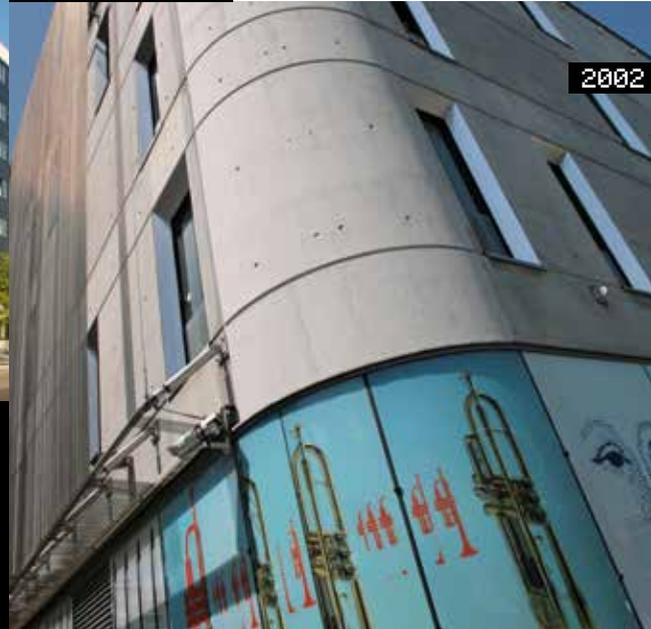
C'est un vaisseau de béton, verre et métal, en forme de triangle aux pointes arrondies, avec une base vitrée animée de nombreuses fresques, au-dessus de laquelle 3 étages en béton sont recouverts de câbles verticaux en inox servant de pare-soleil.
