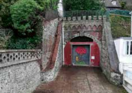
Tunnel Sainte-Marie, Le Havre
